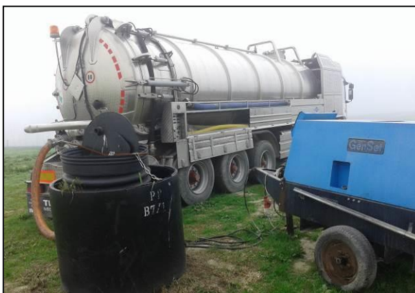
Figura 6: spurgo di un pozzo di percolato (09.11.2015)
