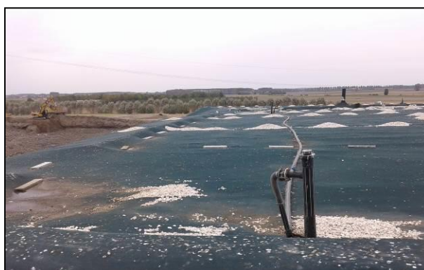
Figura 5: teli in LDPE per la copertura provvisoria (01.10.2015)
