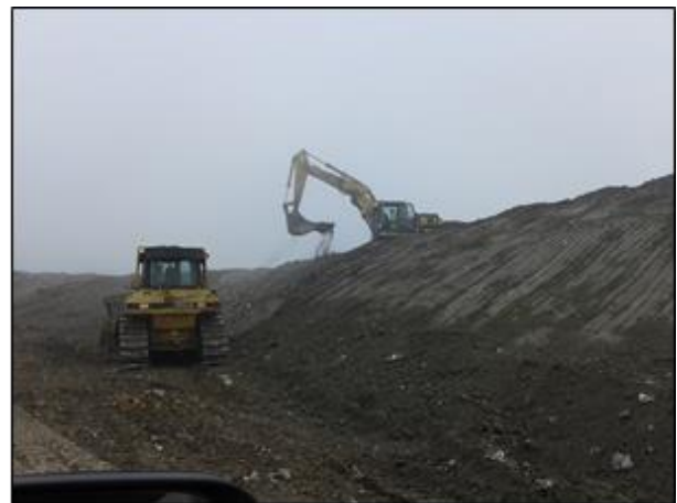
Figura 4: Operazioni di copertura dei rifiuti con terreno (09.11.2015)
